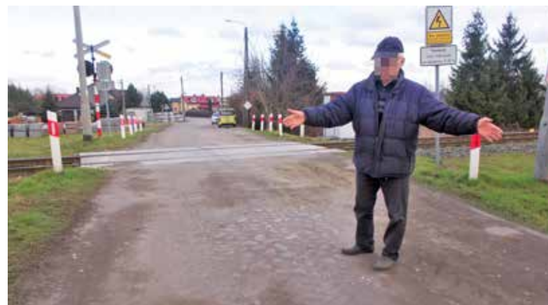
Mieszkańcy są zaskoczeni, że przy torach gruntówka nie została utwardzona
