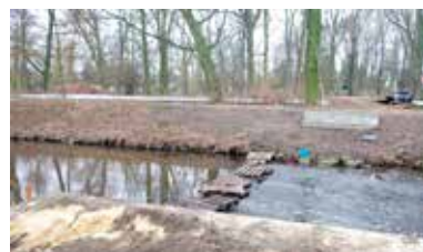
Na razie, zamiast kładki, w korycie rzeki rolę mostku spełniają wyłożone palety
