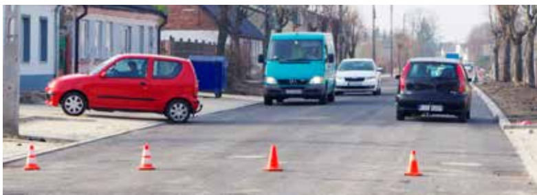
Pomimo znaków kierowcy i tak wjeżdżali na remontowaną ul. Łęczycką
