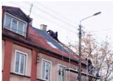
remont dachu zostanie wykonany w przyszłym roku - mówi Izabela Dobrynin, rzecznik ozorkowskiego magistratu.
