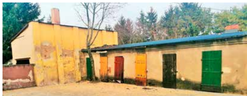
Po wyjaśnieniu sprawy, „Zieleń” mogła dokończyć utwardzanie terenu
