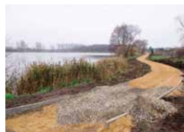
W pierwszym tygodniu grudnia zakończą się prace przy budowie ścieżki dla pieszych nad zalewem. Inwestycja realizowana jest w ramach Budżetu Obywatelskiego 2019. Jej koszt to blisko 120 tys. zł.
