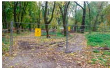
Od strony Lidla, póki co, prace remontowe alejek zostały wstrzymane
