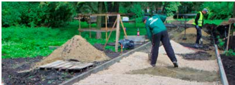
Modernizacja alejek od strony ul. Traugutta
