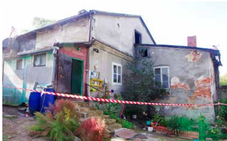
W budynku najprawdopodobniej mieszkać już nie będzie można
