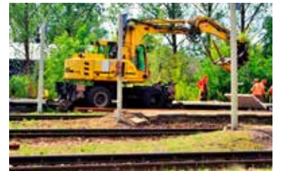
Na dworcu w Łęczycy zamknięte będą tory przy peronie 1 i 2. Konieczna była budowa peronu tymczasowego
