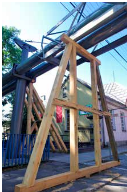
Dodatkowe stemple podtrzymują konstrukcję
