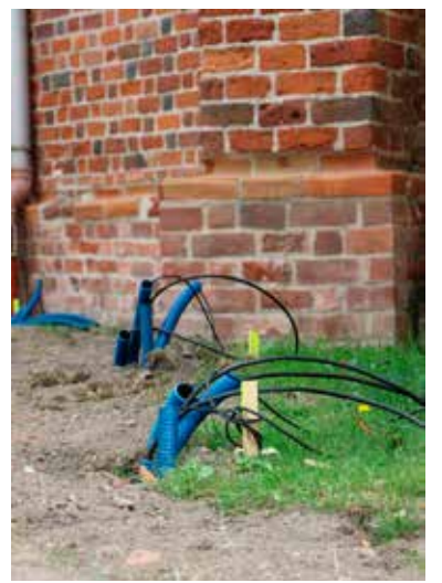
Jak na razie mało estetyczne, wystające z ziemi przewody, niebawem zostaną zamaskowane a w ich miejscu pojawią się punktowe LED-y, które rozświetlą mury XIV-wiecznej Kolegiaty
