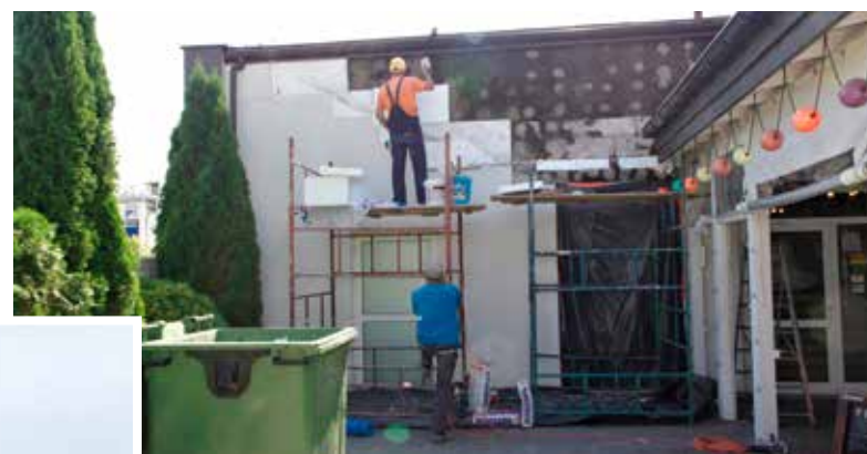
Całe szczęście ogień nie rozprzestrzenił się na drewniane patio. Remont spalonej ściany przebiegł sprawnie
