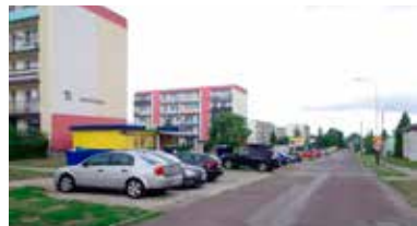
Podczas niedawnej sesji radni rozmawiali o potrzebie remontu m.in. ul. Zachodniej
