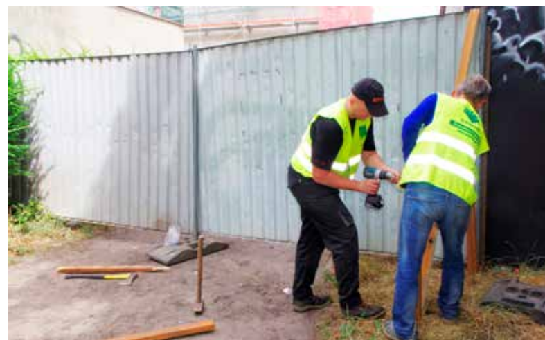
Stawianie ogrodzenia od strony ul. Listopadowej
