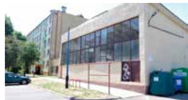
Kotłownia przy ul. Krasickiego 1 należy do spółdzielni mieszkaniowej. Tu także nie planuje się na razie żadnej inwestycji
