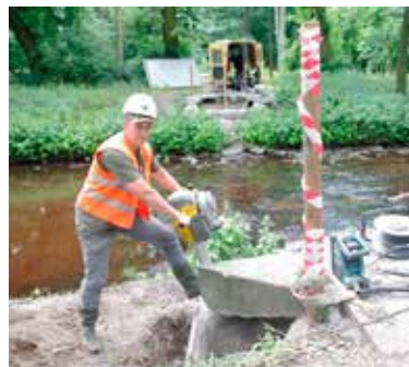
Pod koniec ub. tygodnia rozpoczął się remont mostku. Przyczółki zostaną wybetonowane, nowa kładka najprawdopodobniej zostanie zamontowana w połowie sierpnia.
