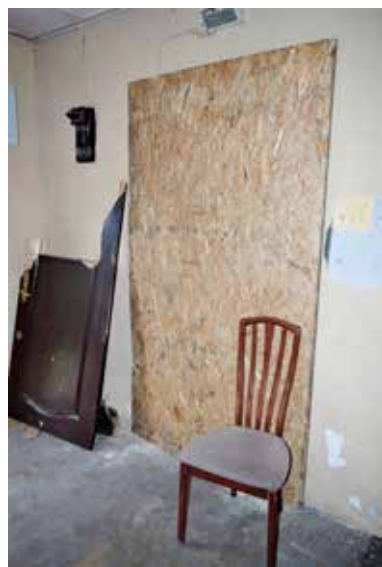
Drzwi do lokalu zostały zniszczone
