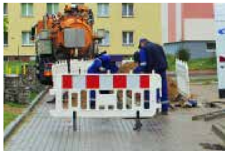
Do wypadku doszło podczas wymiany rury kanalizacyjnej przy ulicy Wojska Polskiego
