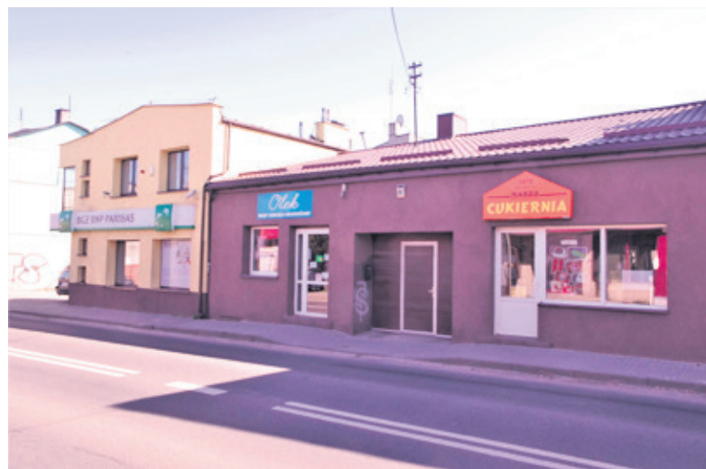
24-latek spadł z dachu budynku bezpośrednio przylegającego do banku
