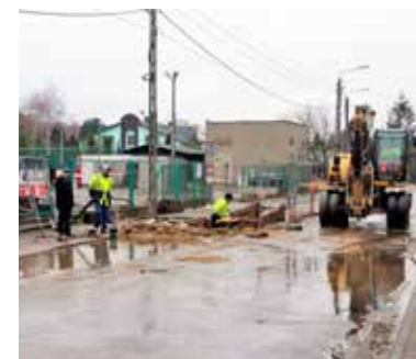
Na Traugutta modernizowana jest sieć wodociągowa i kanalizacja sanitarna. Władze miasta czynią starania, aby ulica była również w tym roku wyremontowana
