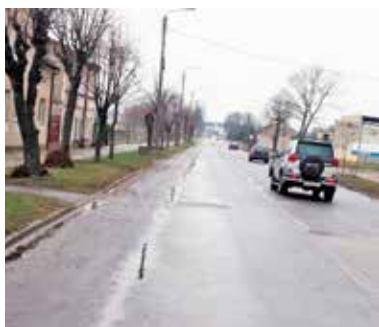
Remont ul. Łęczyckiej – jak zapowiada miasto – w tym roku
