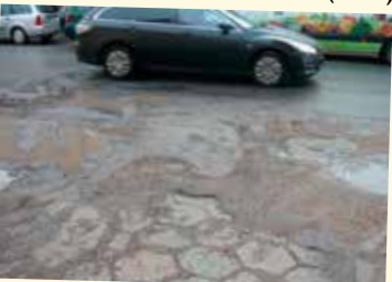
Wjazd na osiedle jest dziurawy i wąski
