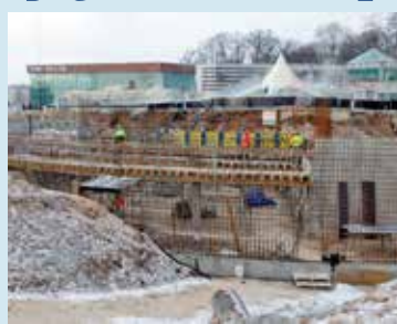
Zarys nowego basenu jest już widoczny
