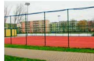
Wykonawca przystąpił do pierwszych prac związanych z montażem lodowej tafli
