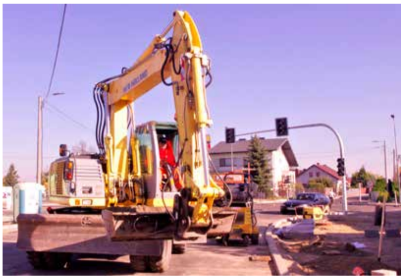
Newralgiczne skrzyżowanie wciąż jest remontowane
