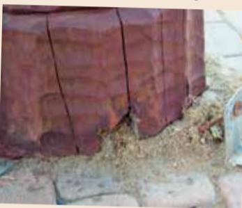
Jedna z podstaw nie jest odpowiednio przymocowana
