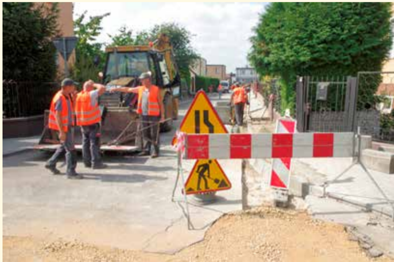
Stara sieć wodno – kanalizacyjna została wymieniona m.in. w ul. Morelowej
