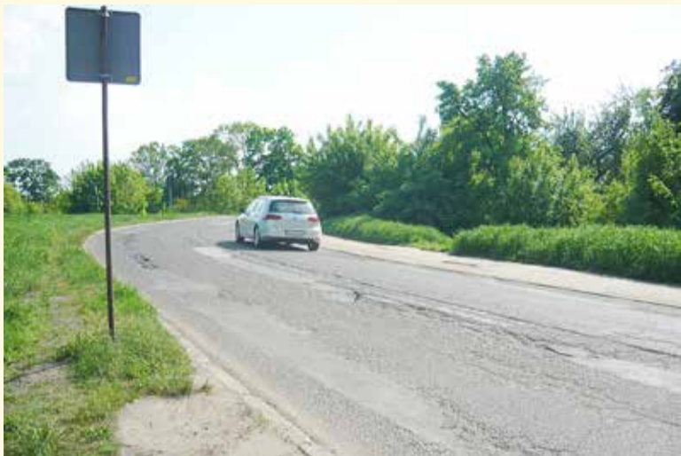
Powiat łęczycki nie ma pieniędzy na wyremontowanie nawierzchni drogi na wiadukcie
