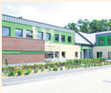
Nowa siedziba nadleśnictwa kosztowała ponad 6 mln zł. Budynek został oddany do użytku pod koniec ubiegłego roku
