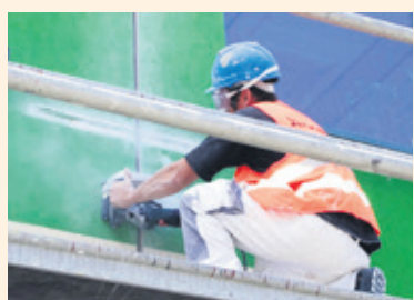
W elewacji wykonywane są pionowe i poziome nacięcia
