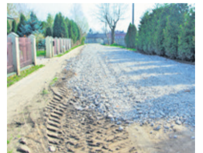
Na ulicy Jagiełty wysypywany jest betonowy gruz
