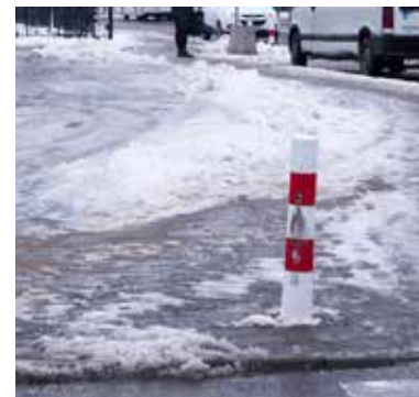
(zz) W czwartek słupki zostały wyprostowane
