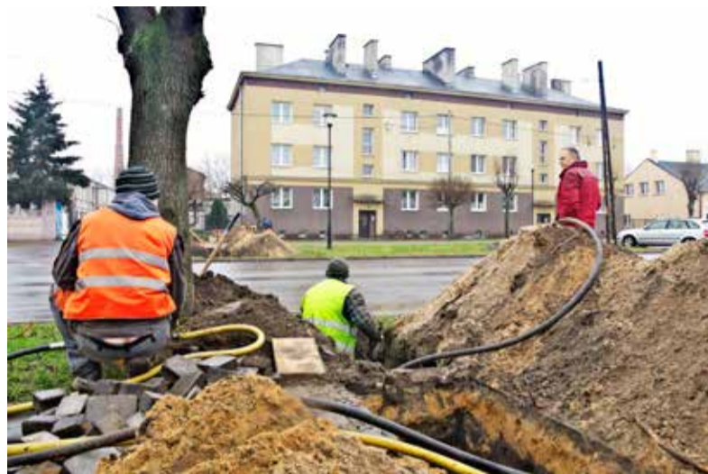
Wśród do kamienicy przy Wyszyńskiego podciągnięty został gaz
