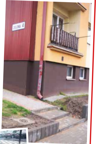
Przy bloku, obok schodów, zrobiony też został zjazd
