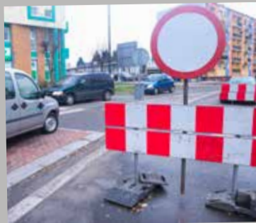
Droga wciąż jest remontowana. Kierowcy nie zwracają na to uwagi
