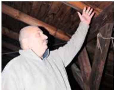
- Czekamy na kompleksowy remont dachu – mówi lokator
