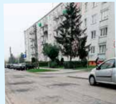
Nowa metoda została użyta m.in. na ul. Dominikańskiej
