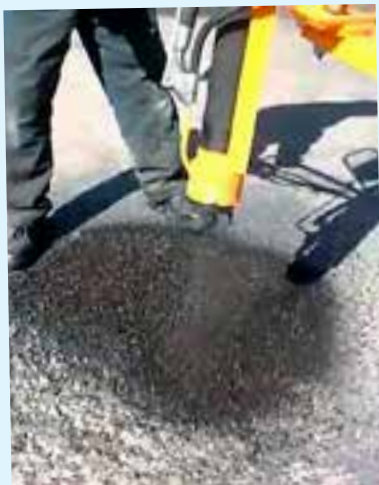
Podczas łatania patcherem, do dziury wysypywany jest drobny grys
