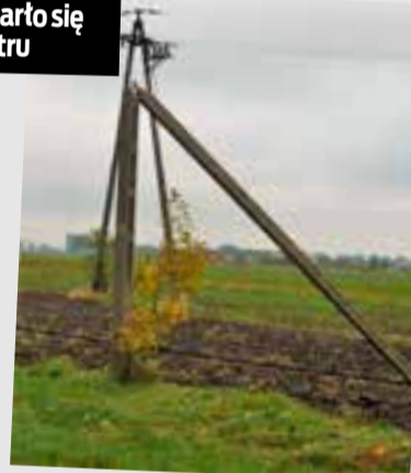
Betonowe słupy również uszkodził potężny wiatr
