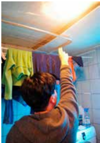
W łazience pani Elżbiety oderwały się panele z sufitu przez przeciekający dach. W innym miejscu wciąż kapie woda
