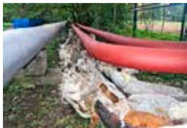
W wielu miejscach stara izolacja ciepłociągu została zerwana
