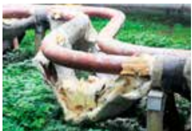
W wielu miejscach stara izolacja ciepłociągu została zerwana
