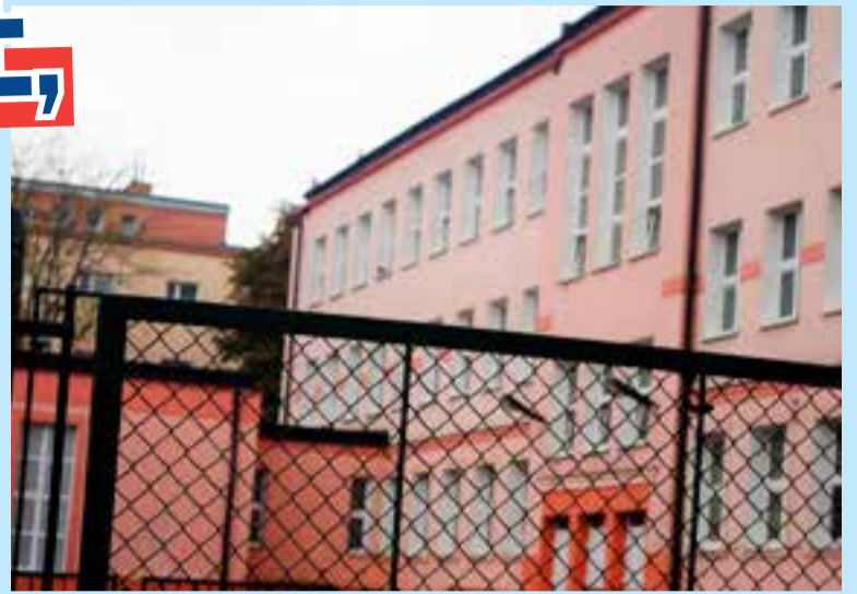
Uczeń przez chwilę stał na zewnętrznym parapecie na drugim piętrze budynku
