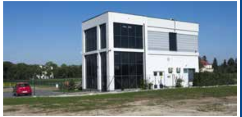
Geotermia przejęła infrastrukturę ciepłowniczą. Sporządzono nową taryfę dot. ciepła
