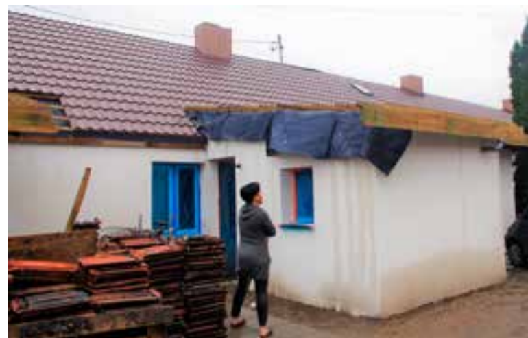
Pierwszy z budynków jeszcze nie jest skończony. Okna wciąż są zastonięte folią
