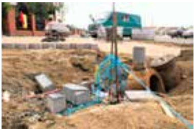
Niektóre prace trzeba było wstrzymać z powodu wystających studzienek gazowych
