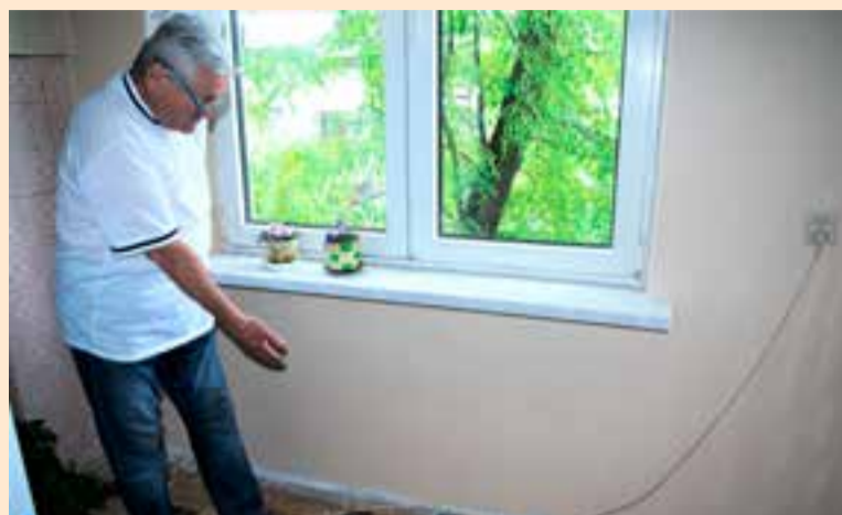
Pan Stanisław nie ukrywa zdenerwowania z powodu przeciągających się prac. Pyta, kiedy w mieszkaniu będzie miał kaloryfer.
