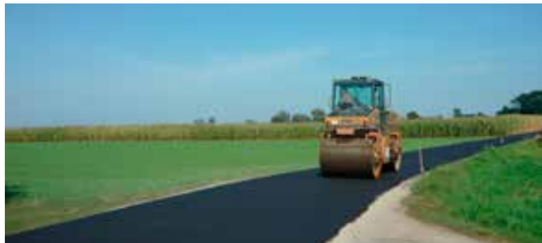
W Kurzjamie droga już została wyasfaltowana
