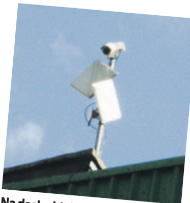
Na dachu bloku zainstalowana została kamera
