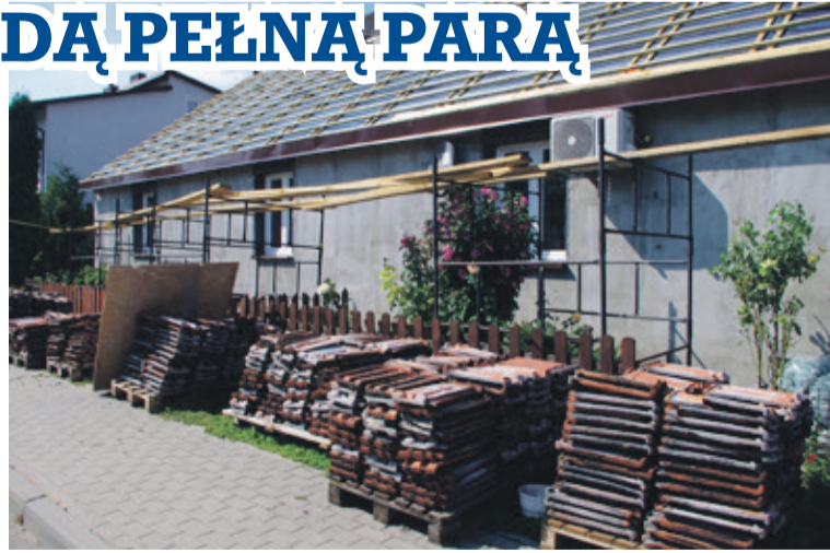
W dwóch budynkach w Daszynie założone zostaną nowe dachówki
