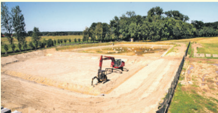
Niedługo zakończyć się mają prace przy budowie drugiego zbiornika
