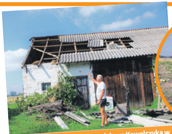
Wichura zerwała dach u Stanisława Kowalczyka w Starej Żelaznej
