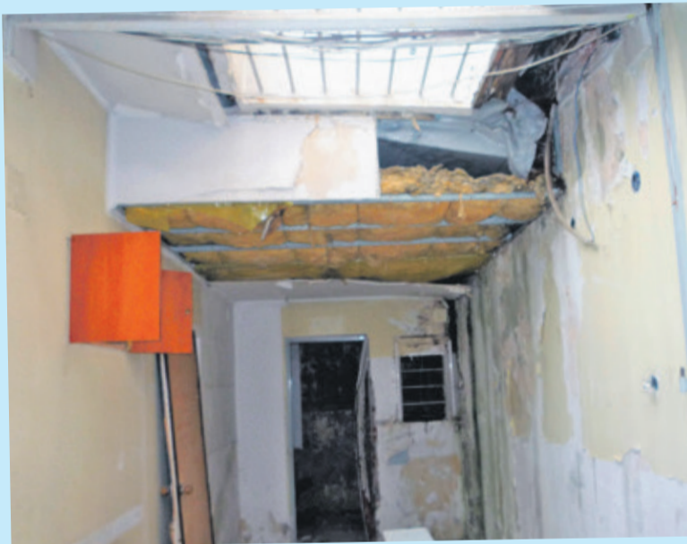
Zrujnowane wnętrze bazy przy ul. Kilińskiego
