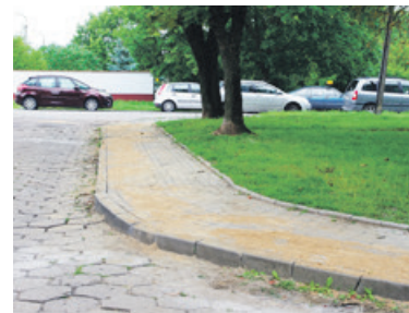
W piątek chodnik został wyrównany a słupki usunięte
