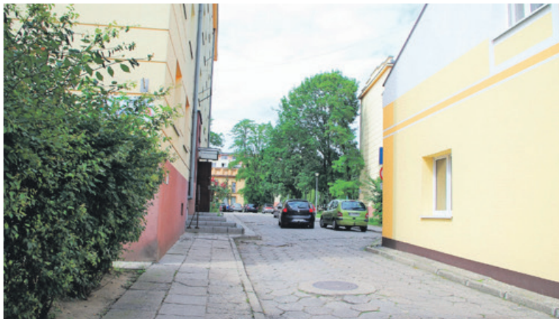
Wjazd na osiedle nie zostanie zamknięty na czas remontu
