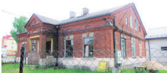
Nie wiadomo, czy budynek wielorodzinny zostanie wyremontowany, czy nie
