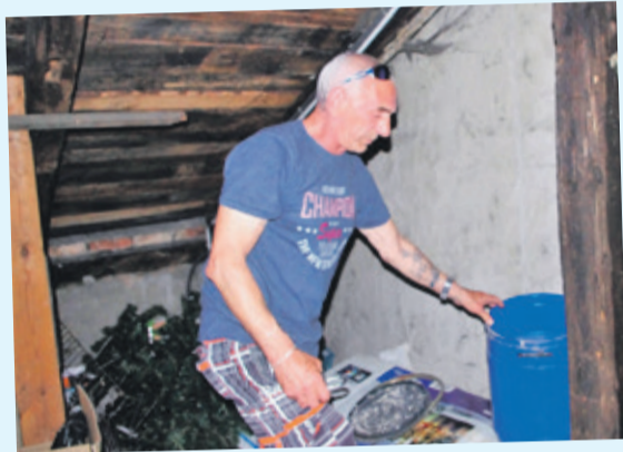
Na strychu deski dachowe i belki są przesiąknięte wodą. Od środy pod dziurą w dachu stoi beczka na wodę. Zbiera jednak deszczówkę tylko z jednego miejsca, do mieszkania i tak przecieka
