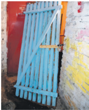
Pożar był w komórce w piwnicy jednego z bloków
