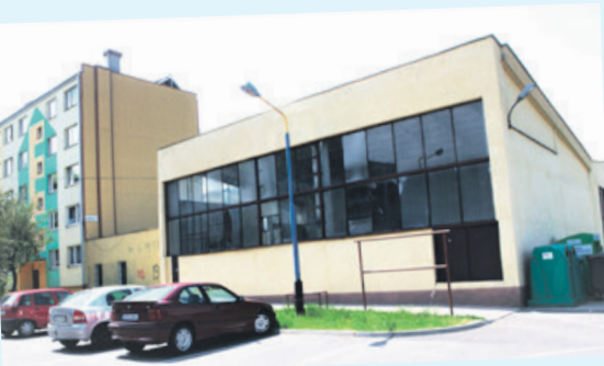
Kotłownia przy ul. Krasickiego zostanie przekształcona w budynek mieszkalny
