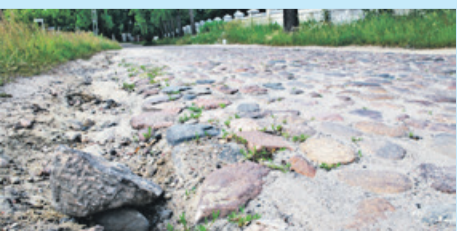
W tym roku na pewno remontu tego odcinka ulicy nie będzie
