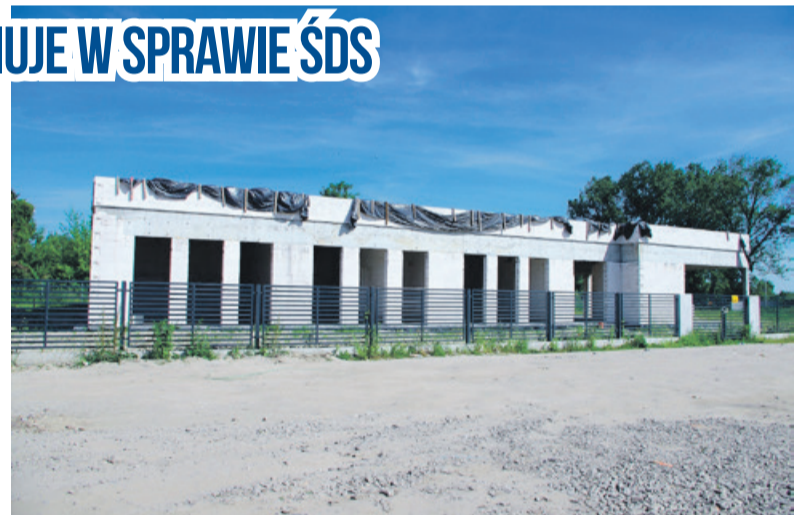
Budynek ŚDS od ponad pół roku stoi w stanie surowym otwartym
