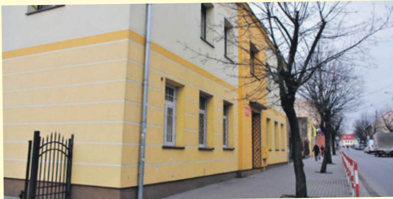
MOPS potrzebuje więcej pomieszczeń. Czy zostanie przeniesiony z ul. Ozorkowskiej na ul. Szkolną?
