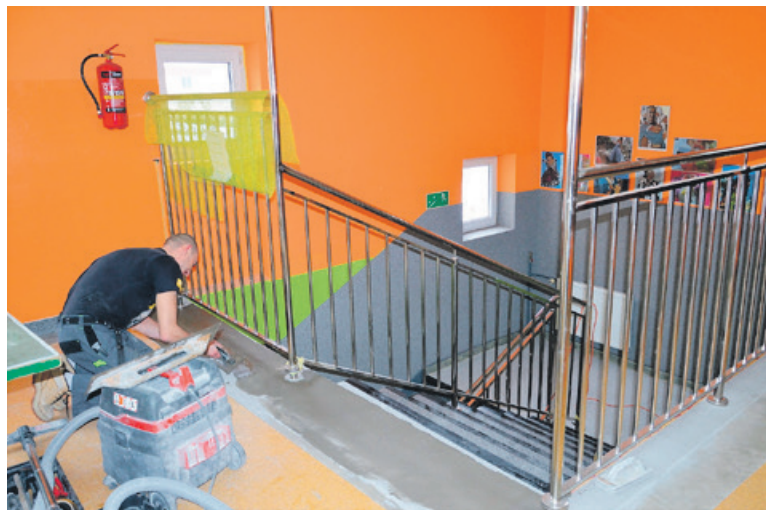
W szkołach trwają remonty
