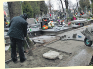
Na alejce układana jest kostka brukowa
