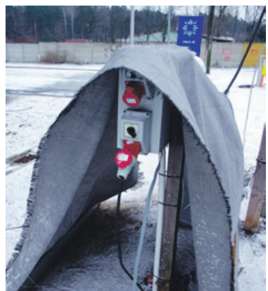
Płachtą przykryte były podłączenia energetyczne
