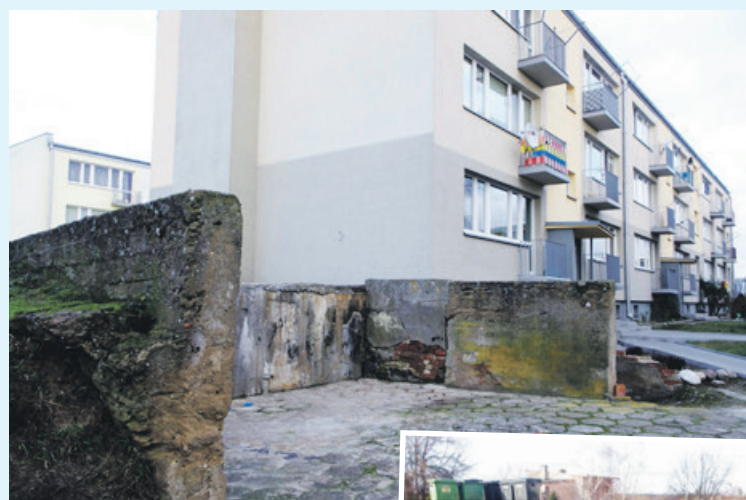
Z dachu tej przyblokowej kotłowni spadł 45-letni mężczyzna
