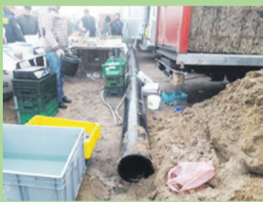
Przez remont ul. Poznańskiej handel i ruch na ul. Przedzrynek również jest utrudniony
