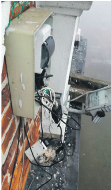
Obudowa kamery na wieży zamkowej jest zniszczona
