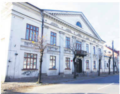
Remont zabytkowego pałacyku jest już zaplanowany
