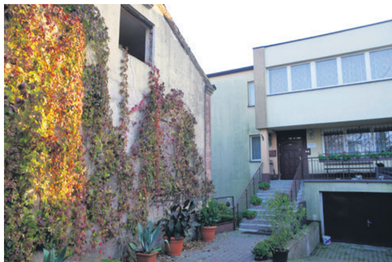
Zabytkowa ruina, która grozi zawaleniem, znajduje się blisko plebanii
