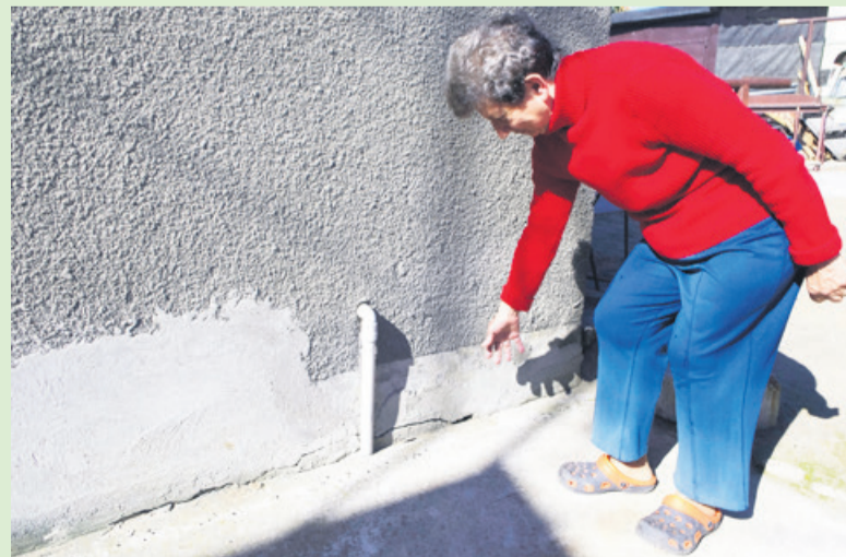
Elewacja pęka od wibracji z zakładu - twierdzą mieszkańcy
