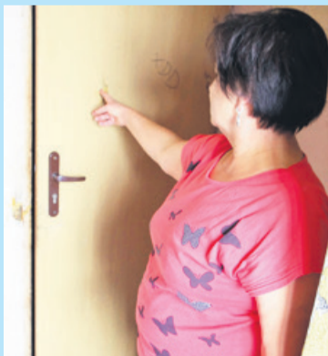
Jedna z lokatorek bloku pokazuje zniszczone drzwi
