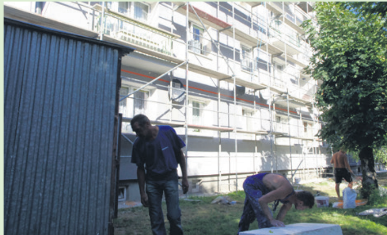
Robotnicy zapewniają, że remont bloku wykonywany jest fachowo
