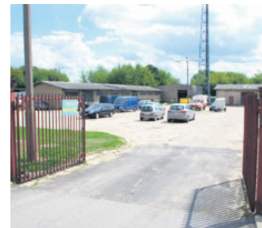
Budynki z azbestem na dachach mają zostać wyburzone. Kiedy? Tego nie wiadomo
