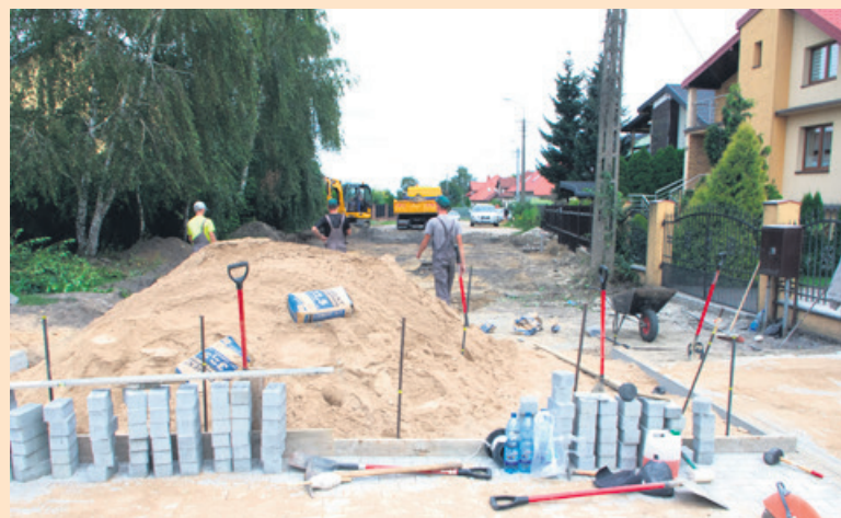
Burmistrz postawił brukarzom ultimatum. Do końca tego miesiąca mają zakończyć remont ul. Broniewskiego na Waliszewie. Jeśli tego nie zrobią, w przyszłym roku inwestycje drogowe wykonywać ma firma zewnętrzna
