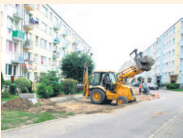
Parking przy Sikorskiego zostanie wyasfaltowany
