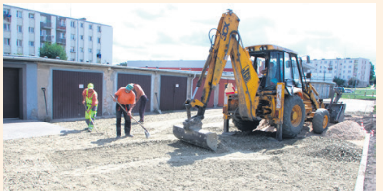
Utwardzanie terenu przy garażach na Bema
