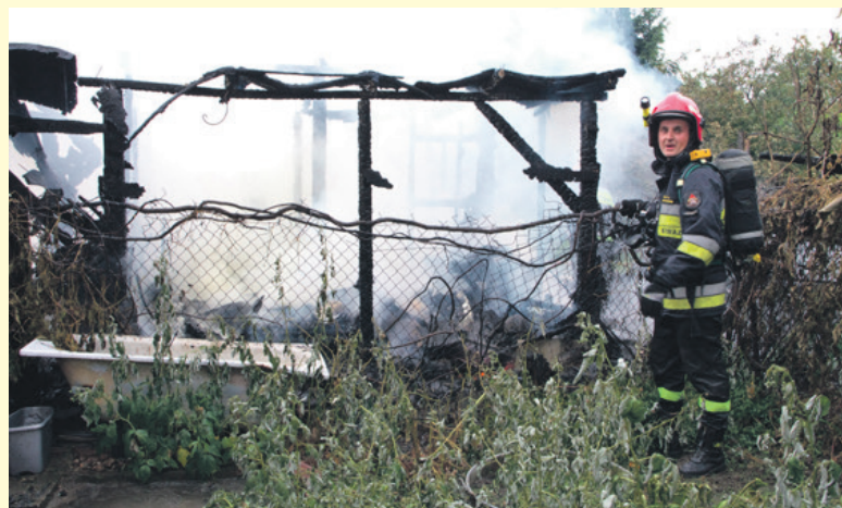
Ogień szybko strawił drewnianą konstrukcję
