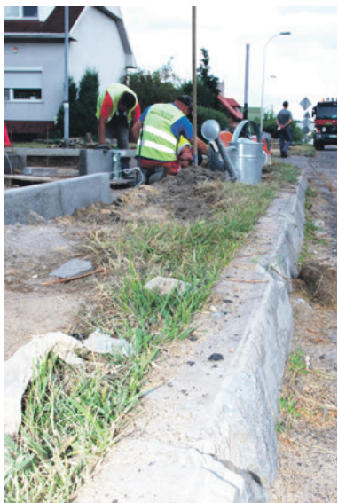
Na szczęście stare krawężniki zostaną wymienione
