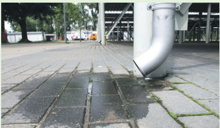
Spusty rynien mają zostać wpuszczone wprost do sieci
