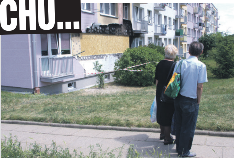
Elewacja bloku została już zabezpieczona
